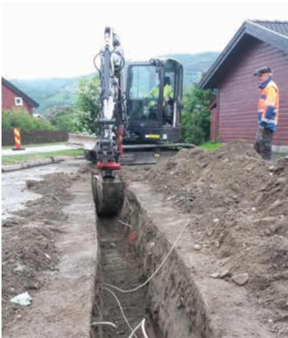
Nedgraving av fibernett for breiband. Foto: Eidefoss.
